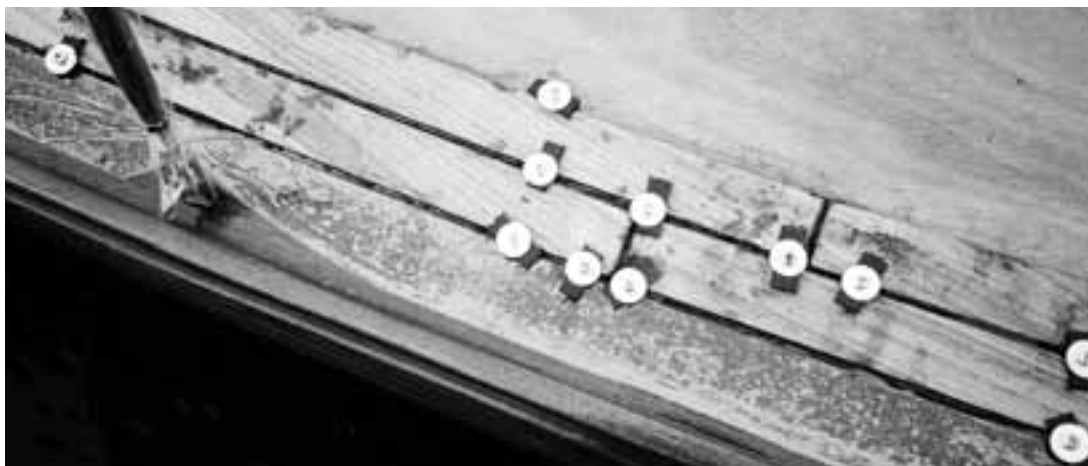
Plasseringen av skruene, som samtidig er avstandsstykker for fugebredden, er viktig. På den øverste teaklisten til høyre i bildet er skruen satt for langt fra skjõten. Det gjør at listen blir rett det siste stykket før skjõten.
